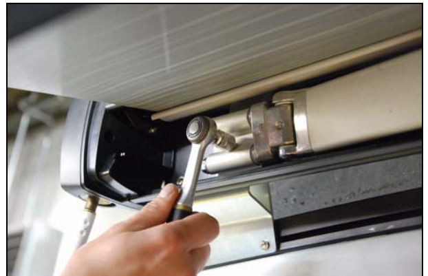
Abb.: vordere Sechskantschraube leicht festziehen
