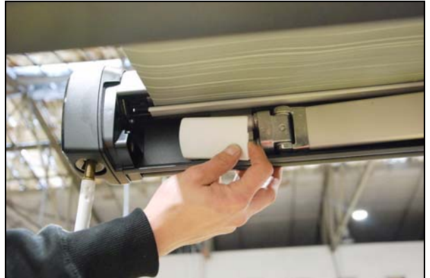
Abb.: vordere Halterhälfte zum Anzeichnen anlegen
