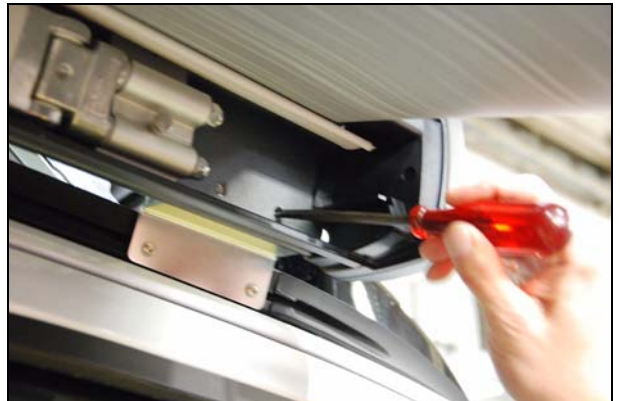
Abb.: Schrauben in den vorderen Halter eindrehen
