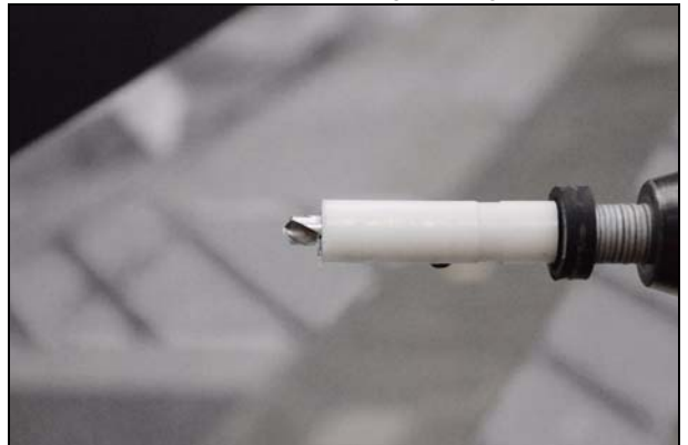
Abb.: 8-mm-Befestigungslöcher bohren
